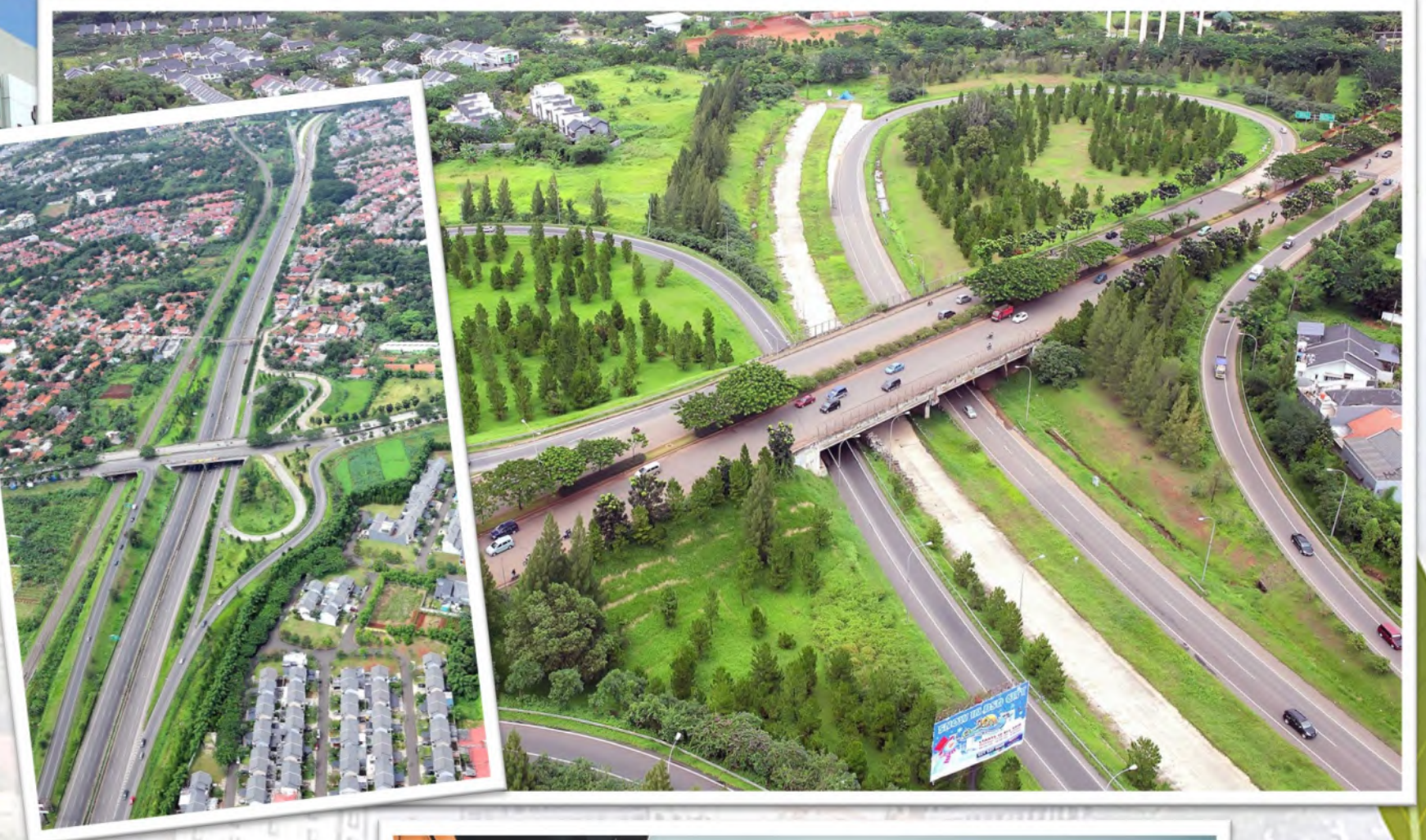
2 Pintu Tol Serpong-Jakarta ►
