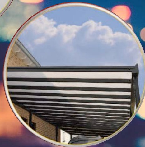
Glass Canopy Carport Utama
